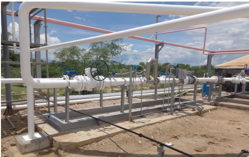
Skid de medición de calidad del gas CPF Maria conchita - Quadranti 2021
