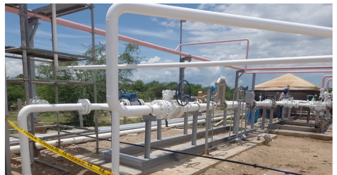
Skid de medición de calidad del gas CPF Maria conchita - Quadranti 2021
