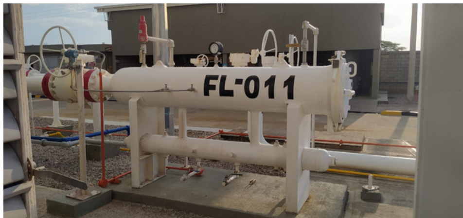
Filtro separador - Estación compresora la paz 2016
