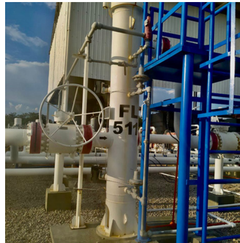
Filtro coalescente - Estación compresora la paz 2016
