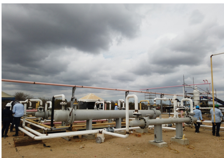
Sistema de ajuste Dew Point CPF Maria Conchita - Quadranti 2021
