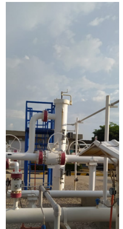
Filtro coalescente - Estación compresora la paz 2016
